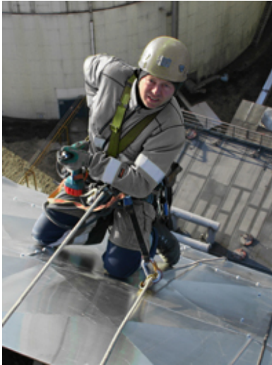
Verticaal valbeveiligingssysteem met flexibele ankerlijn en lijnklemmen
