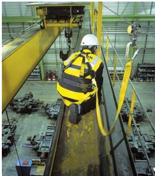
Voorbeeld van een Fall-arrest (valstop) systeem
