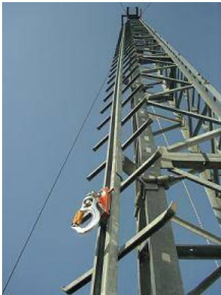
Verticaal valbeveiligingssysteem met starre ankerlijn en vangwagens
